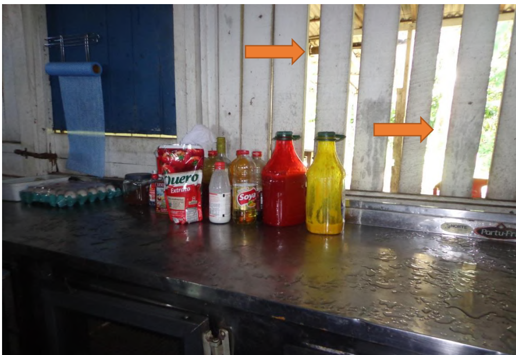
Figuras 2, 3 e 4 CAOTEC/ GATI: estrutura física.
